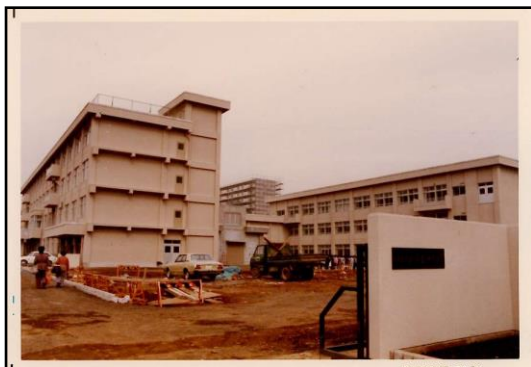
建設中の瑞雲中学校東門
