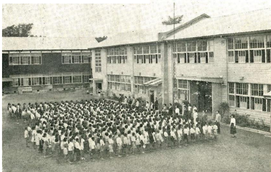
開校60周年(昭和28年)の頃「昭島町立成隣小学校」の校舎と朝礼の様子
