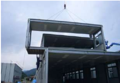
仮設校舎の組み立て開始
