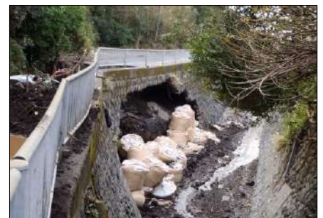
カーブで護岸が削られている
